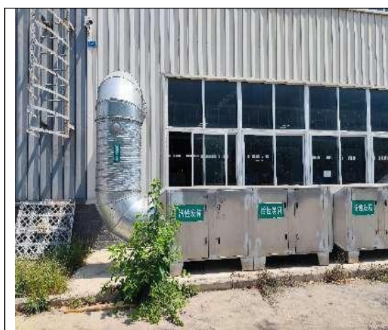
熔融挤出废气两级活性炭吸附装置
