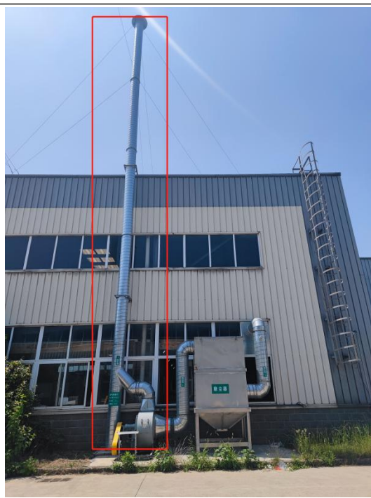
破碎粉尘废气排气筒
